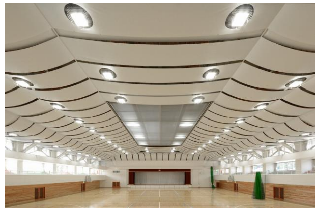
耐震改修工事で天井材として「シルフィーファイン」を採用した「三朝町総合スポーツセンター」
