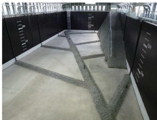
クローズド型処分場擁壁の事例
