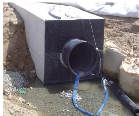
排水管の埋込み部の事例
